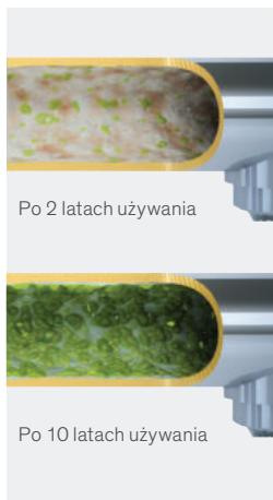
Wnętrze armatury bez regularnego czyszczenia
